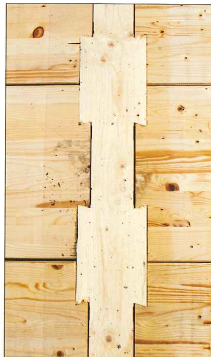
Le système de «queue d'aronde» est entièrement façonné par des machines à commandes numériques.
