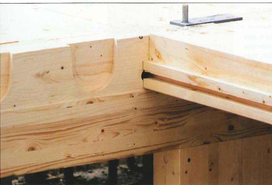
Élément de plancher avec passage de gaine électrique.
