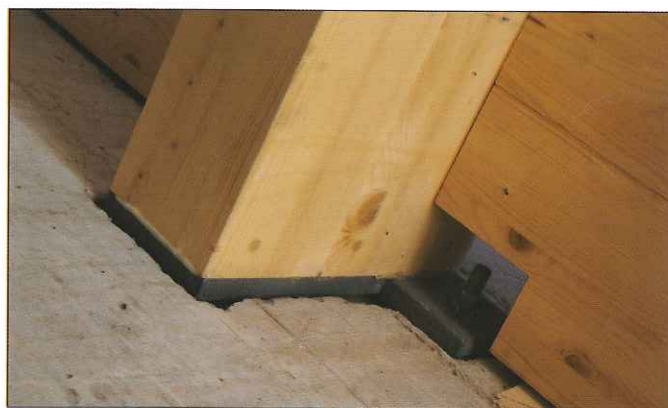
Détail du système Ferwood pour paroi intérieure.
