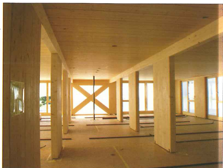
Le même système de poteaux/poutres utilisé en façade l'est aussi pour les parois intérieures qui, assemblées sur toute la hauteur au moyen du système Ferwood, assurent le contreventement du bâtiment.
