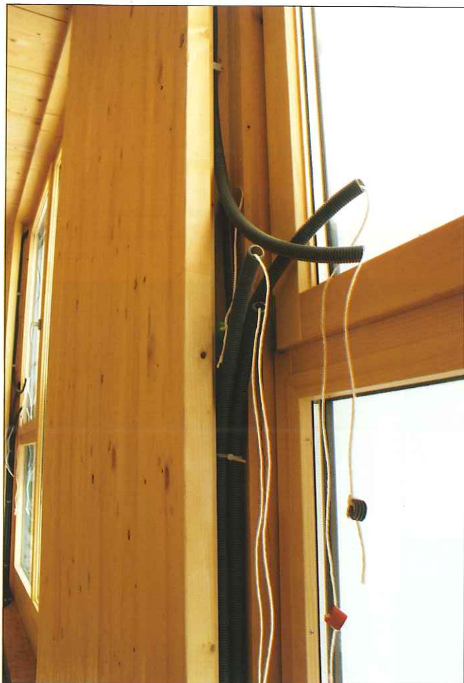
Insertion des câbles électriques du store dans l'encadrement des vitrages.
