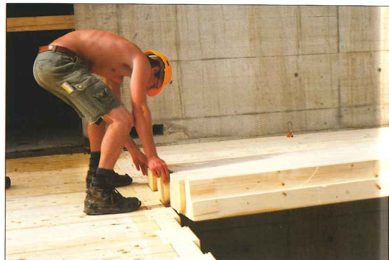
Pose des planchers: constitués d'éléments en bois massif de 40 cm de largeur pour 18 cm de hauteur, ils s'emboîtent dans les sommiers avec le système de «queue d'aronde».
