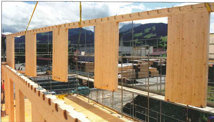
Mise en place des éléments de façade préfabriqués en lamellé-collé.
