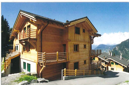
Vue amont immeuble a
