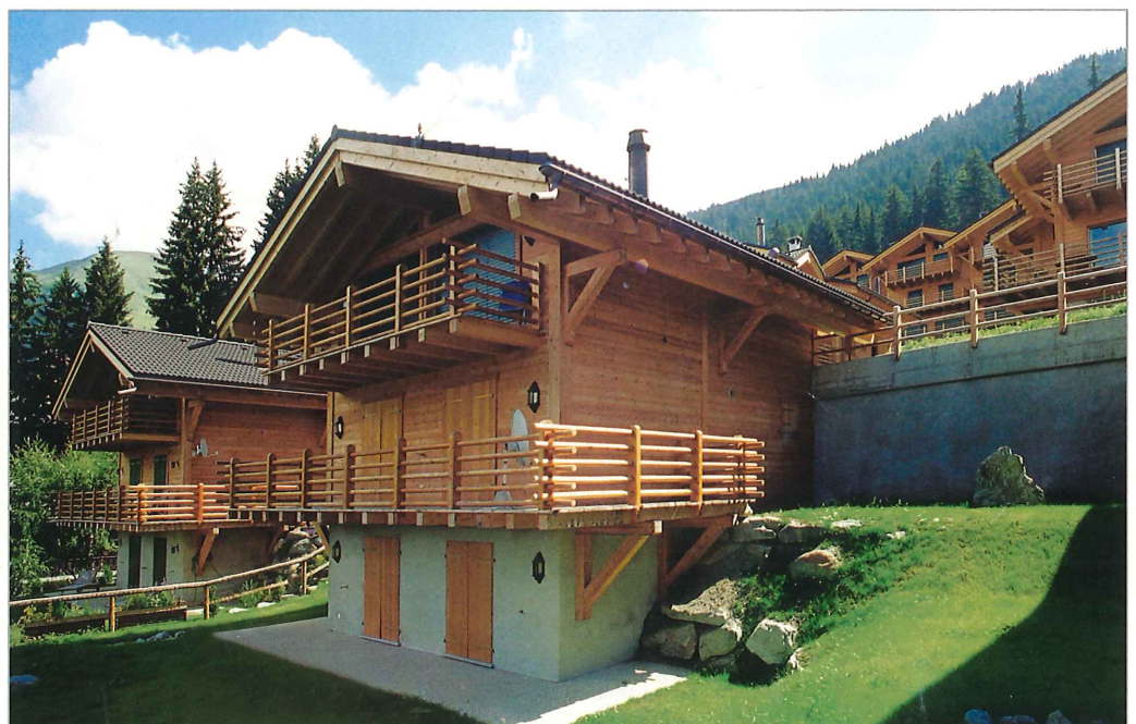
Vue aval chalet c3
