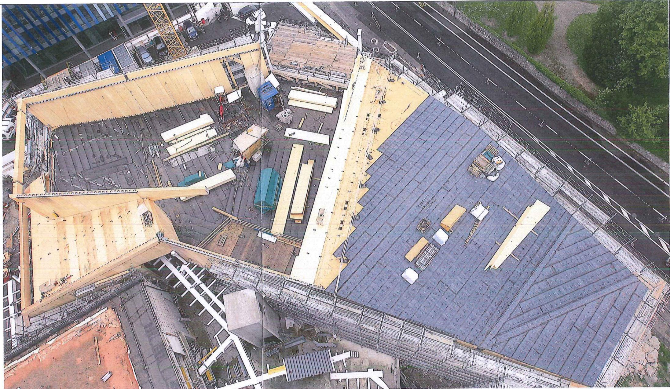
La totalité du bois de la structure provient des forêts suisses, à l'exception d'un mélèze d'Europe centrale pour le revêtement extérieur en tavillons. La part des matériaux gourmands en énergie tel que le verre et le béton a été réduite au minimum. Tous les revêtements intérieurs sont réalisés en bois.
