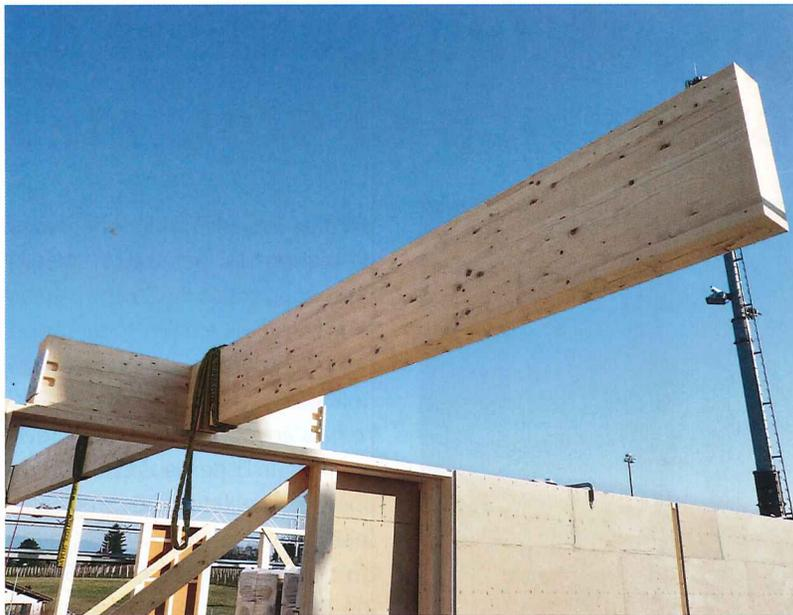
Une panne de toiture supporte le porte-à-faux de l'avant-toit de 4.50 m.
