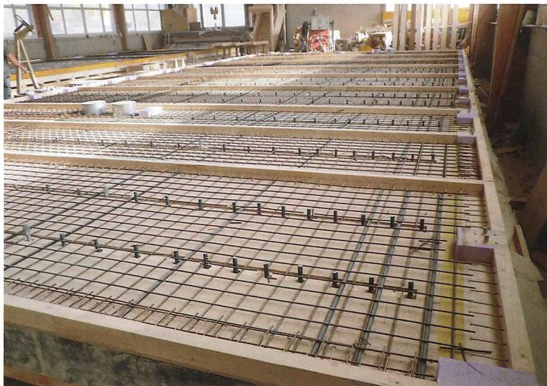
Les dalles mixtes bois-béton préfabriquées sont prêtes à recevoir le béton en atelier.
