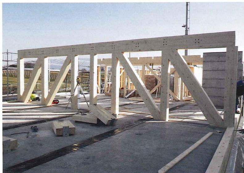
Un porteur en treillis, inclus ultérieurement dans une paroi, supporte les charges au-dessus de la salle polyvalente.
