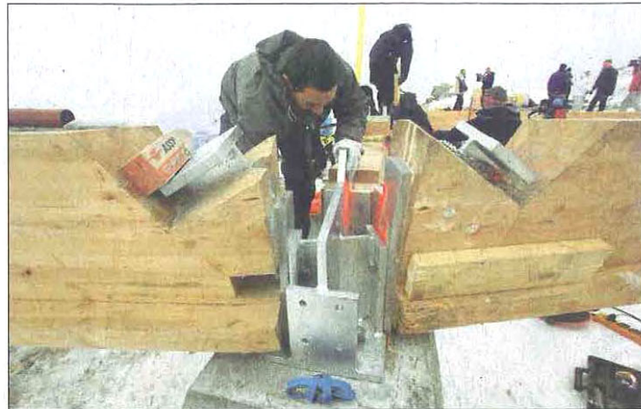
En haut, l'architecte Hervé Dessimoz. «Depuis la salle à manger, les visiteurs auront vue sur Genève.» En bas, les pièces s'assemblent tel un immense jeu de Lego pour former le premier plancher. (PHOTOS LUCIEN FORTUNATI)
