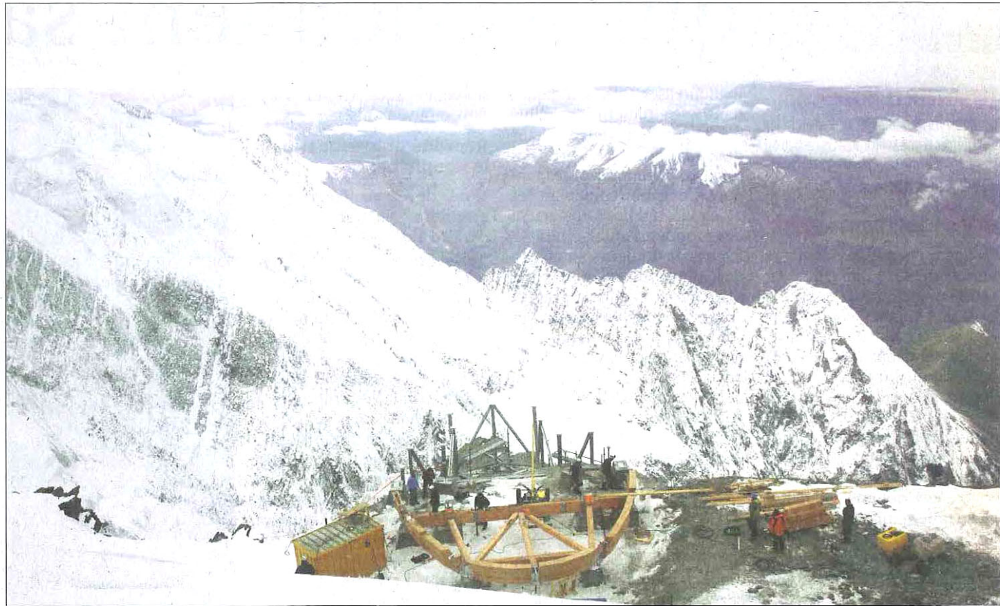
Un panorama époustouflant. Situé à 3835 m d'altitude, le futur refuge du Goûter viendra remplacer l'ancien qui sera démonté.
