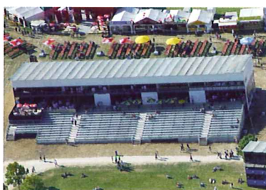
Ancienne structure métallique.
