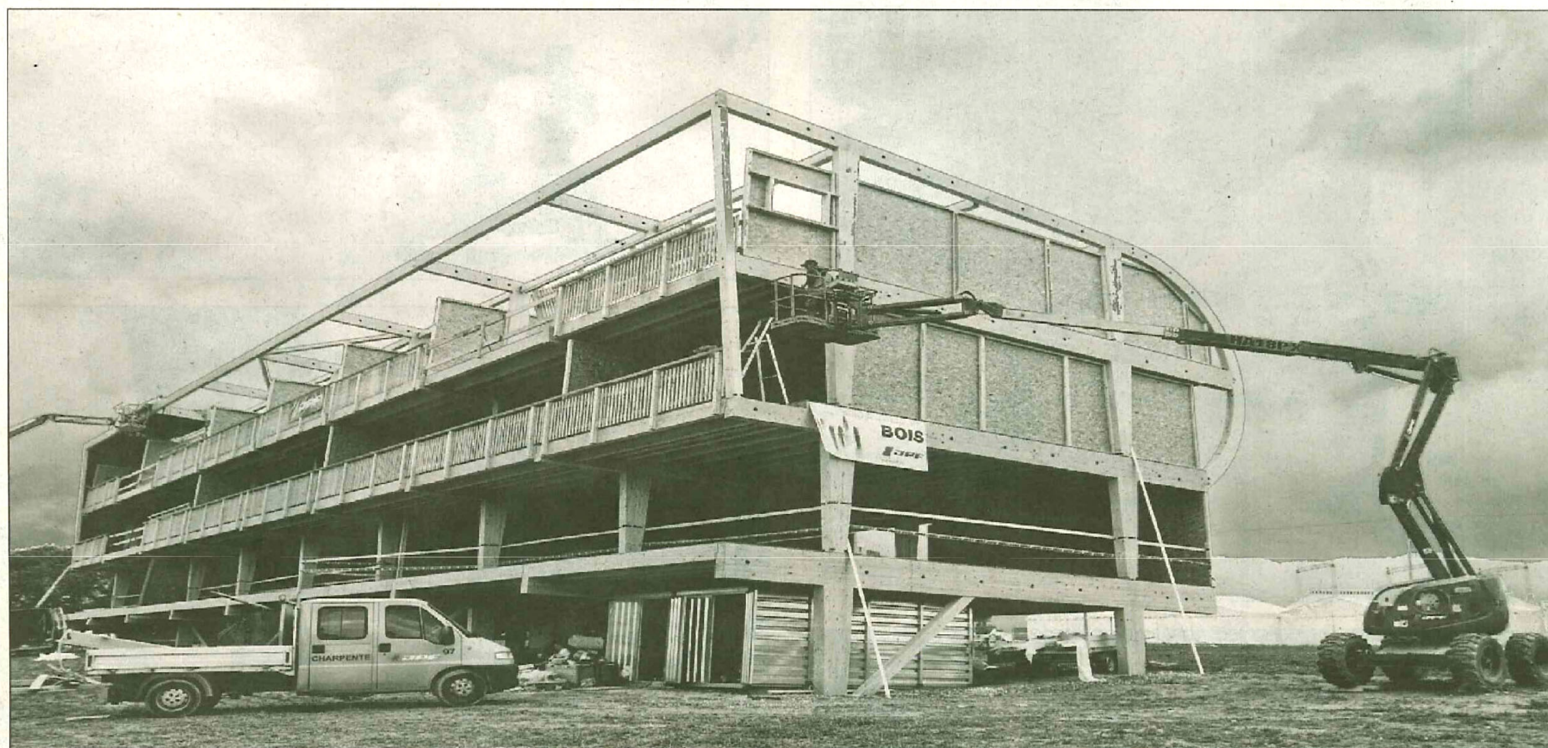
Le travail de cinq ouvriers durant deux semaines a suffi à monter l'imposante structure de bois. JESSICA GENOUD
