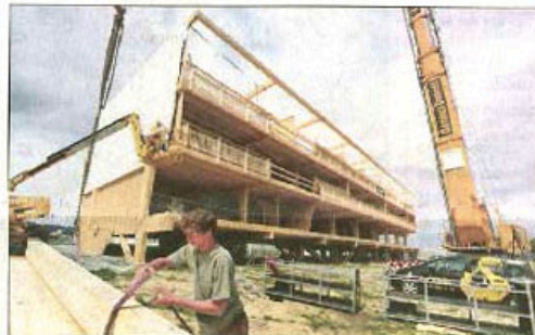
La nouvelle terrasse de Paléo est en cours de montage. Une opération qui durera deux semaines. Le démontage, lui, prendra sept jours.
